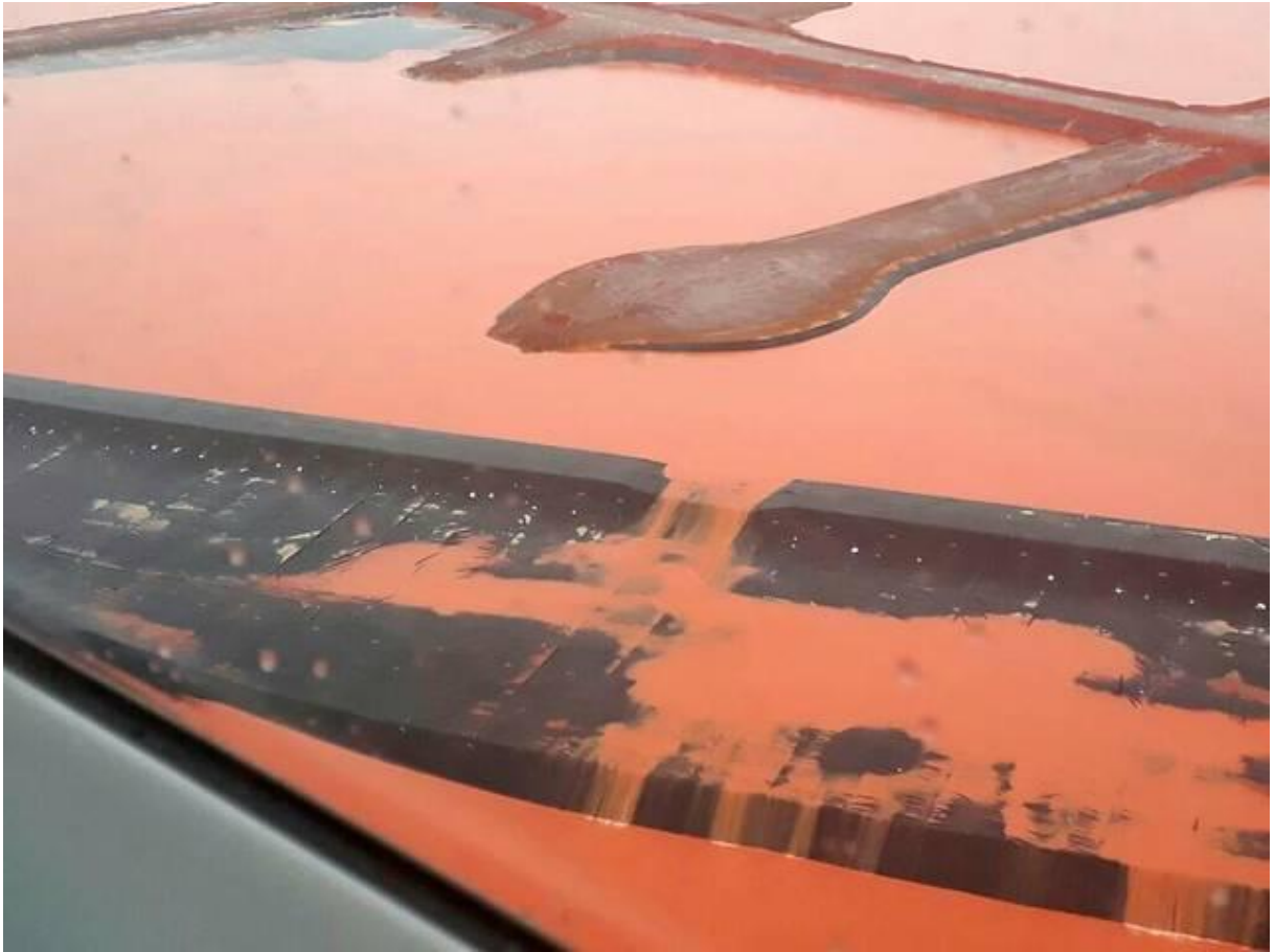
Fotografia 2: Vazamento em bacia da Hydro Alunorte, em Barbacena no Pará (Foto: SEMAS).
